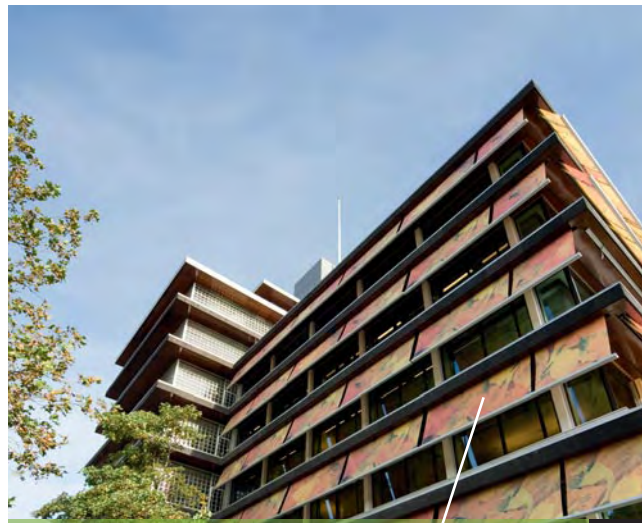
Duurzame energie: provincie Overijssel geeft met haar provinciehuis het goede voorbeeld.
